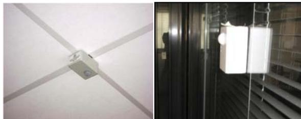
Figure 6 : Détecteur de mouvement disposé au niveau du faux plafond ou sur les cloisons des bureaux individuels.
