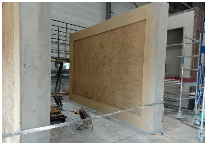
Mur après projection et séchage
