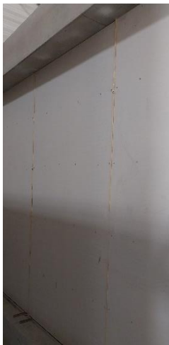
Pose des plaques de fibre-gypse
