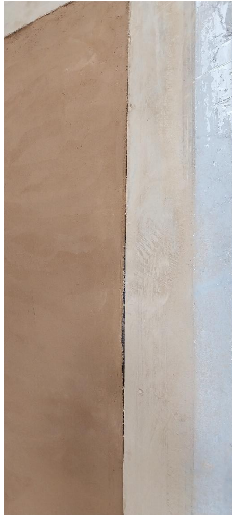
Enduit en terre fibré côté support
