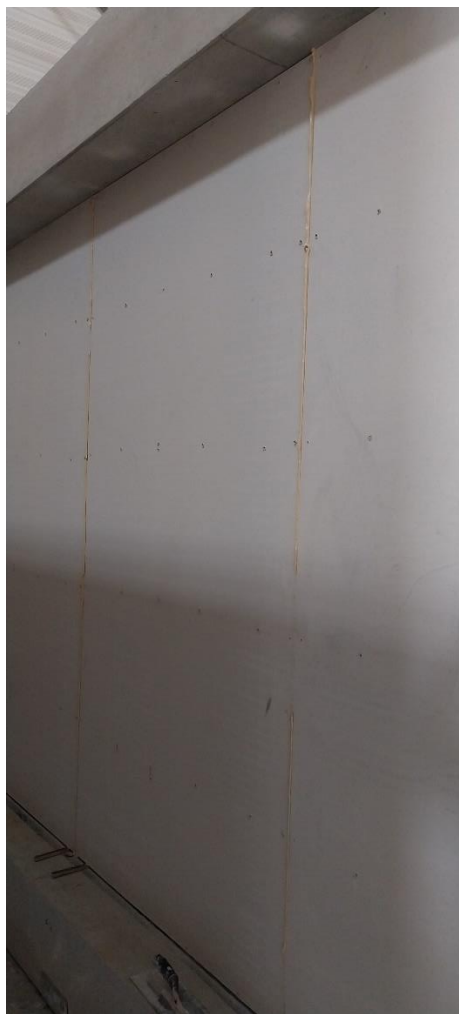
Pose des plaques de fibre-gypse
