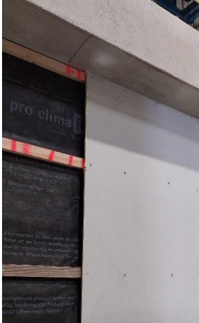
Pose des plaques de fibre-gypse
