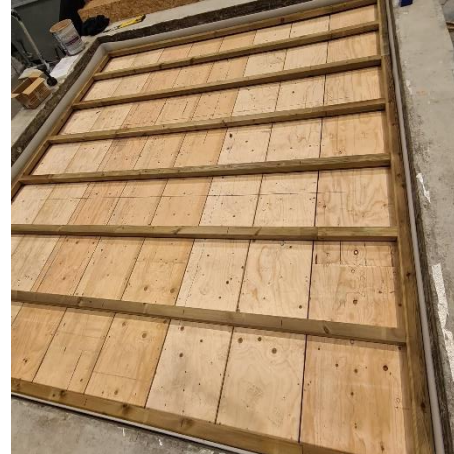
Lambourdes sur plots antivibratiles posées sur le plancher support en bois
