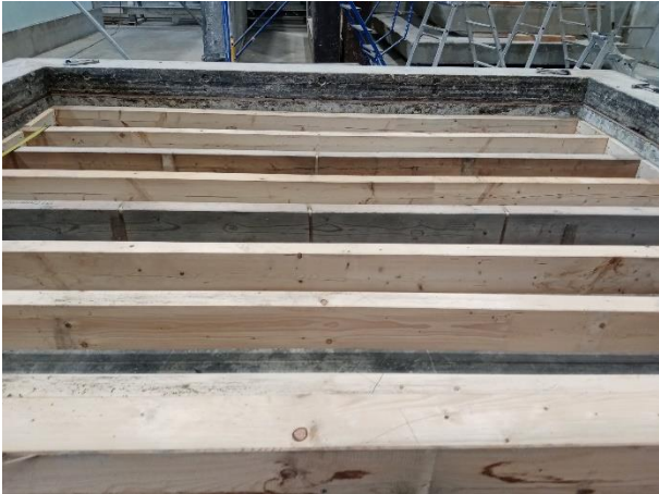
Solives mises en place dans la cadre d'essai
