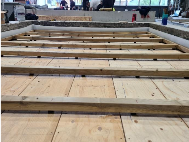
Lambourdes sur plots antivibratiles posées sur le plancher support en bois
