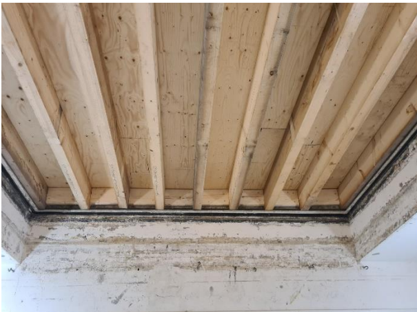
Sous face du plancher (salle de reception)
