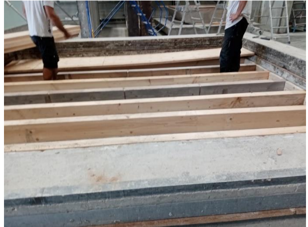
Mise en œuvre des panneaux de bois
