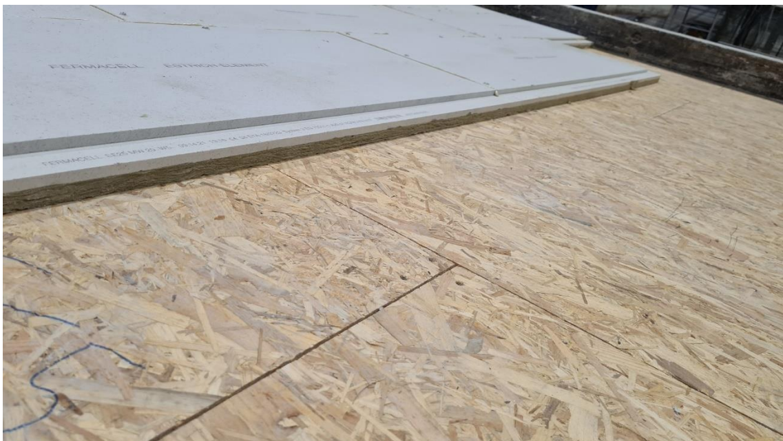
Mise en œuvre de la chape sèche sur le parement OSB
