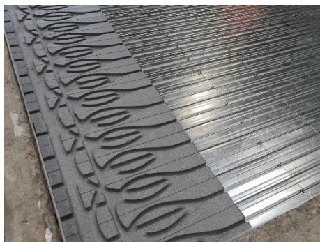
Mise en œuvre du système de plancher chauffant
