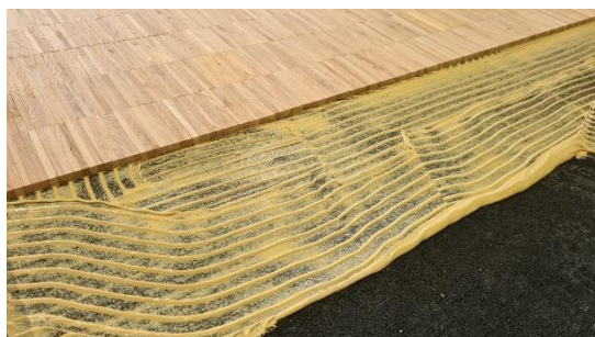
Mise en œuvre du système de parquet (surface du plancher)
