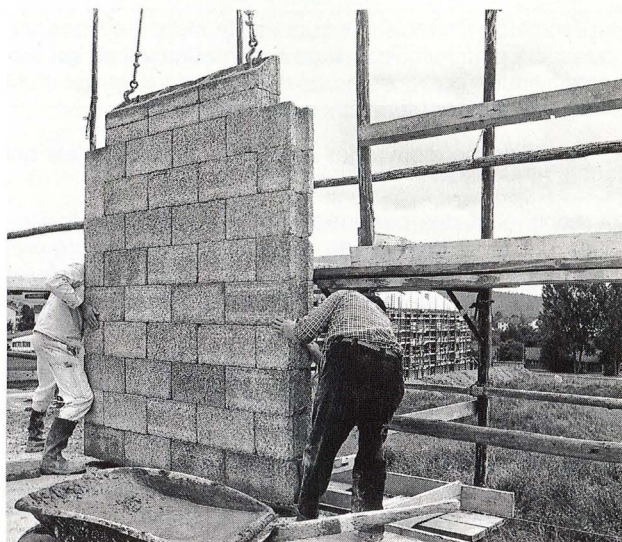
Photo 2 Pose de mur de maçonnerie en blocs de béton de bois banché. Cette maçonnerie est confectionnée au pied du bâtiment puis montée à la grue pour mise en œuvre au niveau désiré
