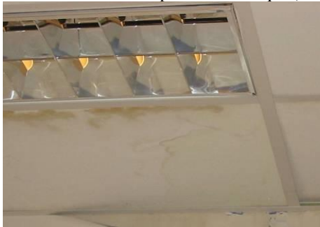
Contamination sur dalle de plafond acoustique (bureau)
