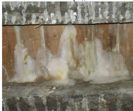
Contamination sur plâtre (chambre)
