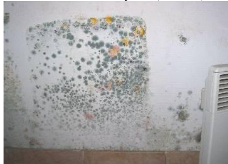
Contamination sur plâtre (chambre)
