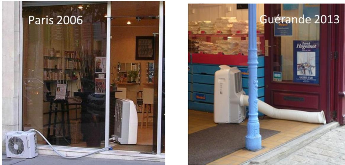
Figure 18 : Installation de climatiseurs dans des conditions sous-optimales dans des commerces
