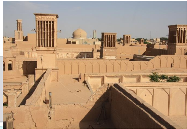
Tours à vent (source : F. Bougrain, CSTB)
