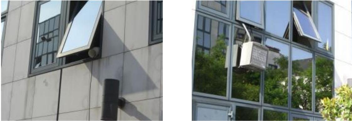
Figure 12 : Installation sans aucune précaution de climatisation individuelle dans un immeuble de bureaux (source : CSTB)
