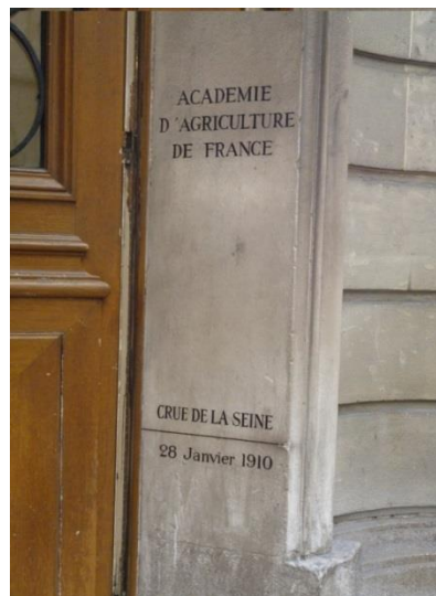
Figure 6 : Laisse de crue de la Seine en 1910 à Paris (photo CSTB)
