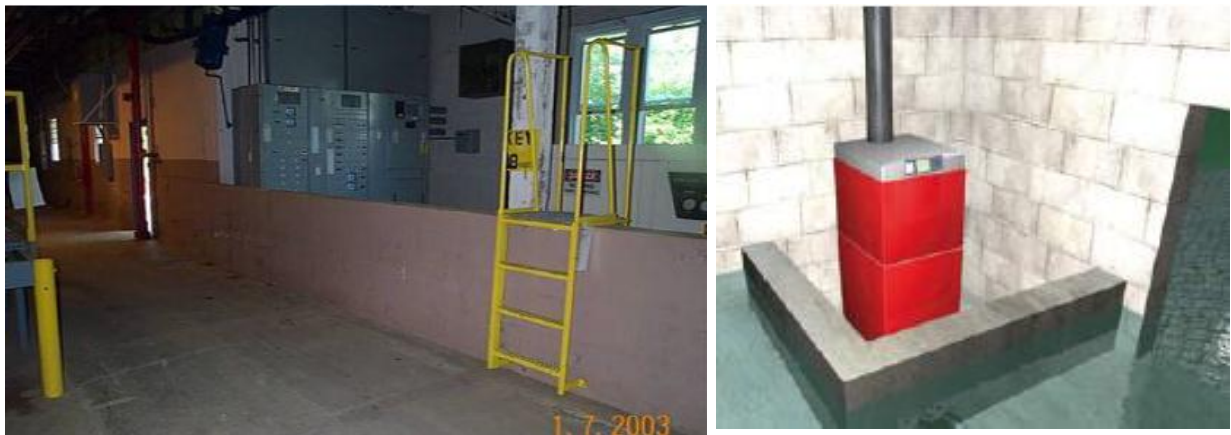
Figure 25 : protection d'un équipement vulnérable par un muret à gauche en site industriel (source FM Global) et à droite chez un particulier (source DGALN, 2012)
