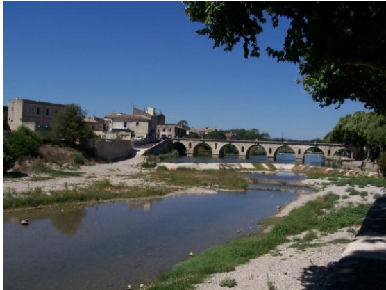
Figure 9 : les arches actuelles du pont de Sommières (source www.sommieres.fr )
