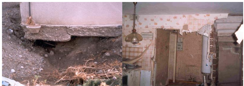
Figure 6 : Cloison séparative probablement détruite par une vague
