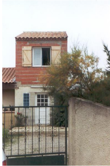
Figure 14 : exemple de zone refuge (source : CSTB)
