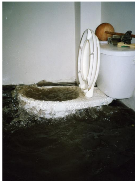
Figure 22 : remontée d'eau par le réseau d'eaux usées (source ENPC-Leesu)
