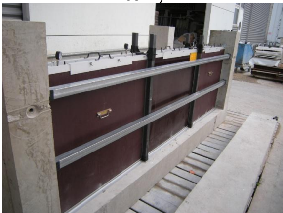
Panneaux avec joints gonflables (produit Colladeau) (photo CSTB)
