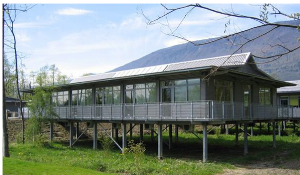
Figure 11 : un des dix bâtiments HOUSE BOAT® au Lac du Bourget (source : www.patriarche.fr )
