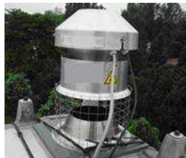
(a) Extracteur classique ou « cape à l'italienne » (b) extracteur stato-mécanique
