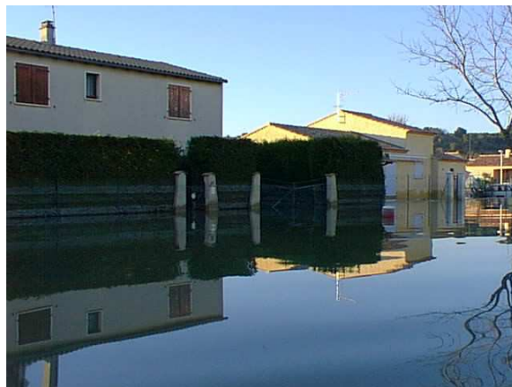
Figure 6 : Inondation de la ville de Bellegarde provoquée par la crue du Rhône en 2003
